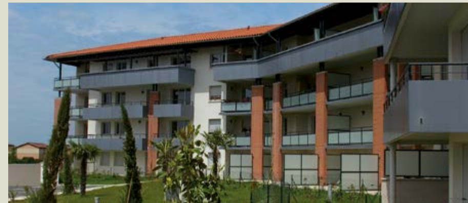
RÉSIDENCE LES BORÉALES - COLOMIERS (31) 56 logements - Arch. JF Martinie
