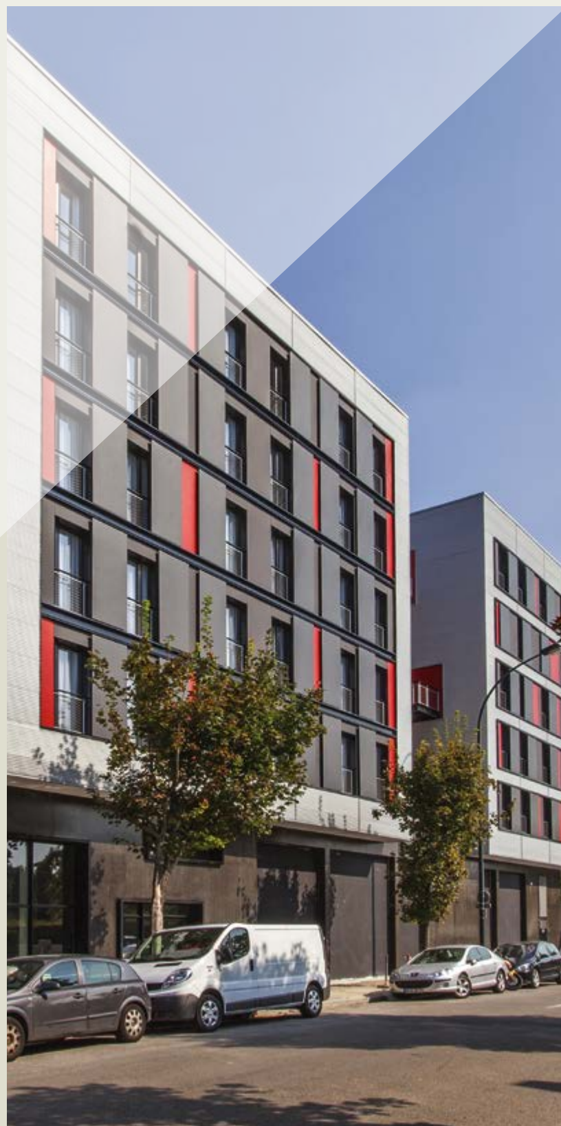
RÉSIDENCE ÉTUDIANTE - ASNIÈRES-SUR-SEINE (92) 230 studios - Arch. Lobjoy et Bouvier - Pietri Architectes
