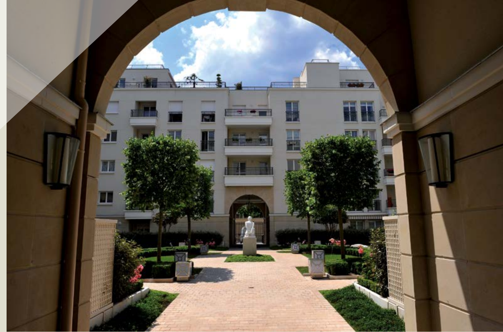
LES JARDINS DU CARROUSEL - ISSY-LES-MOULINEAUX (92) Arch. 3M architectes
