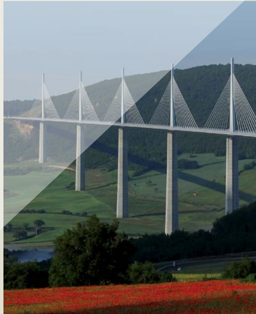
LE VIADUC DE MILLAU - MILLAU (12) Arch. Lord Norman Foster
