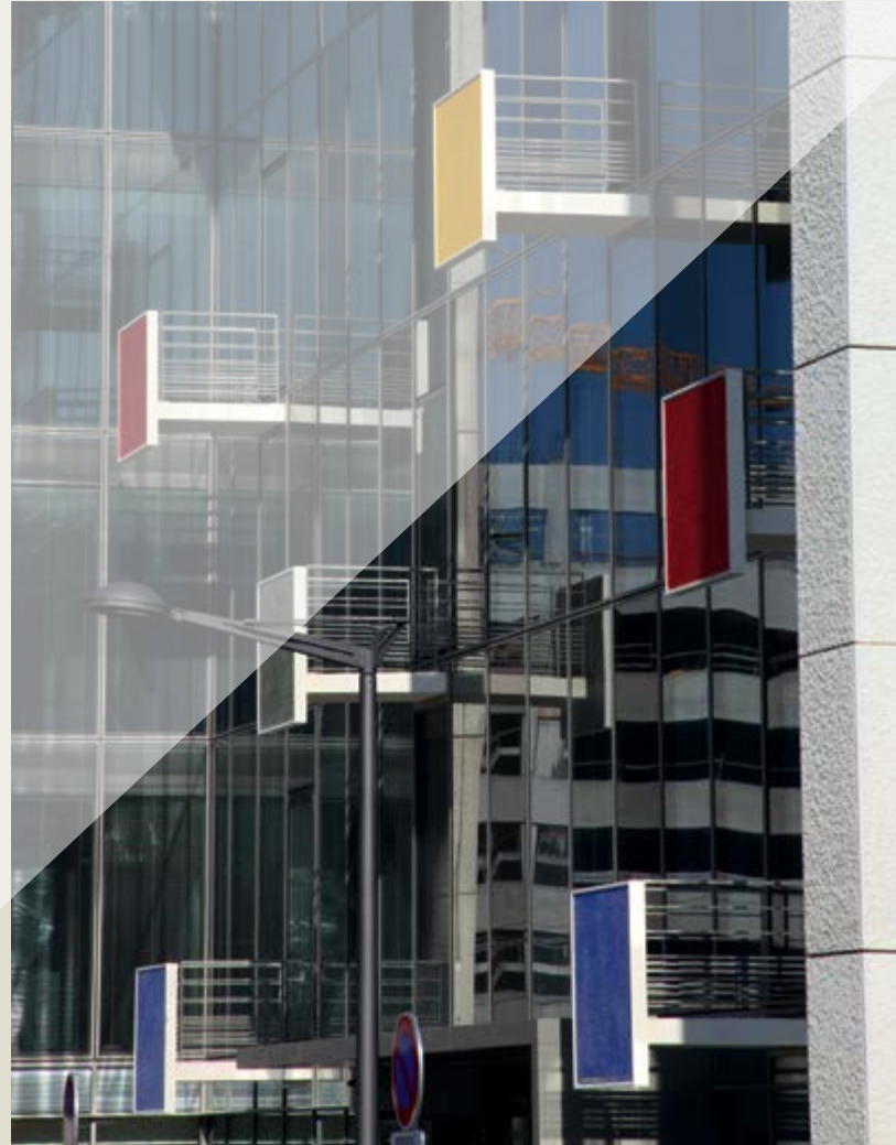
HÉLIANTHE SIÈGE RÉGIONAL DES BRANCHES DU GROUPE EIFFAGE - LYON (69) Arch. AIA - Atelier de la Rize
