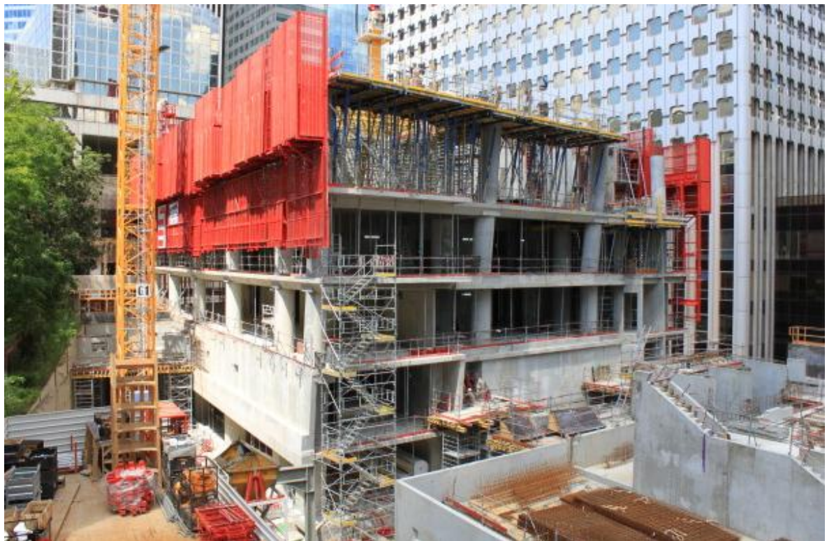
Juin 2012 – Gros-œuvre plancher haut r+4
