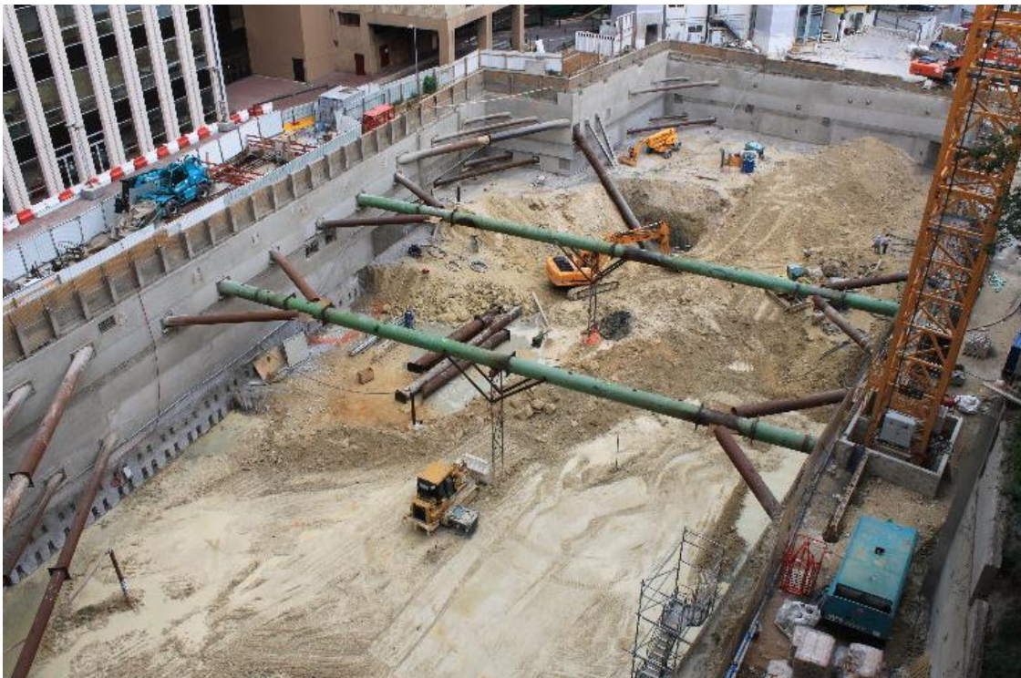
Novembre 2011 - Jet Grouting, forage des profils de parois périmétriques.
