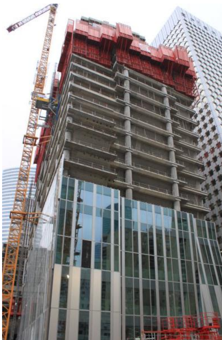
Février 2013 - Façades dix niveaux sous le plancher en cours
