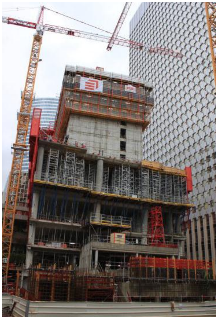
Octobre 2012 - Noyau plancher haut r+5 et plancher haut esplanade
