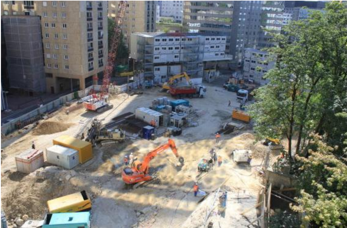
Novembre 2011 - Jet Grouting, forage des profils de parois périmétriques.
